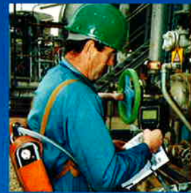
Des contrôles réguliers sont effectués sur le terrain
